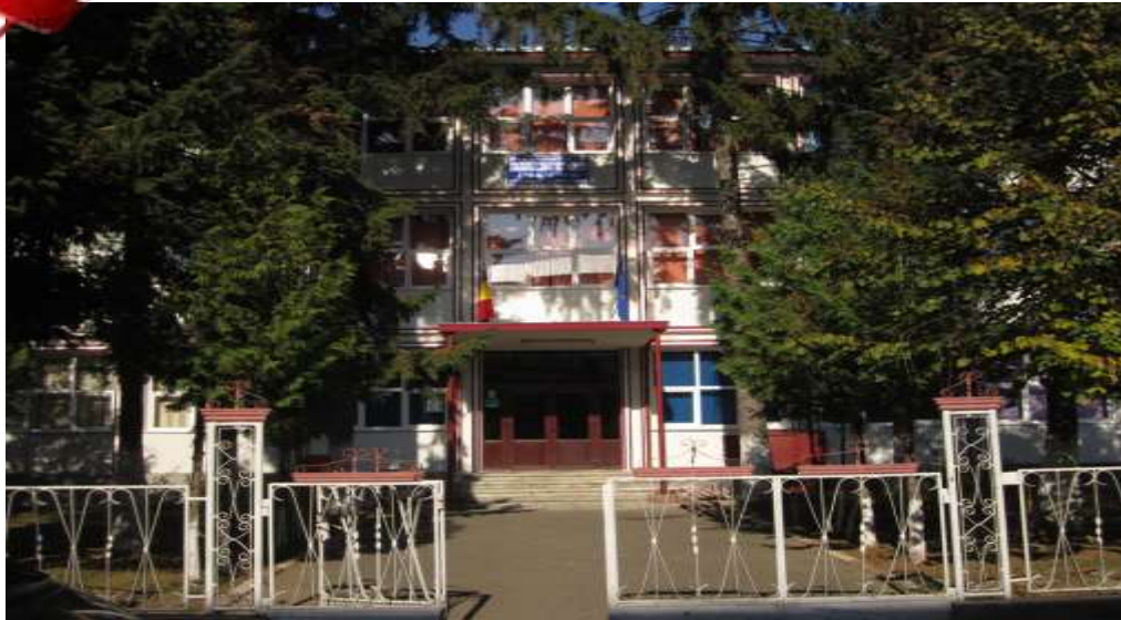
Foto sus: Colegiul Tehnic „Ion Borcea” Buhuși, corpul A Foto jos: Colegiul Tehnic „Ion Borcea” Buhuși, corpul B
